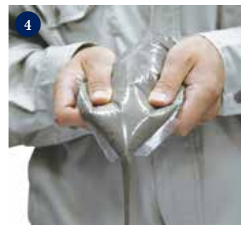
④ パックの切り込み部をカットして グラウトモルタルを押し出します。
