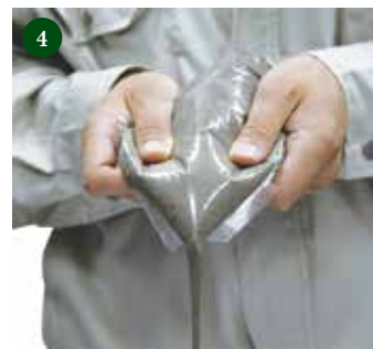
④ パックの切り込み部をカットして セルフレベリング材を押し出します。
