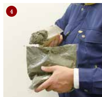
④ パックの切り込み部をカットし コテでモルタルを取り出します。
