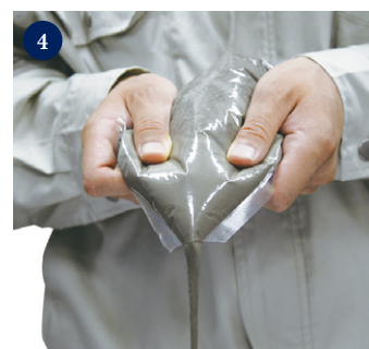
4 パックの切り込み部をカットして グラウトモルタルを押し出します。
