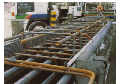
PC 梁段差止め
