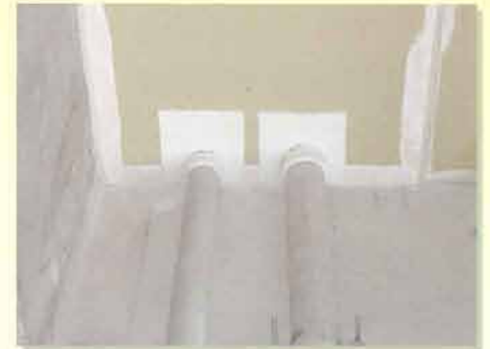
石膏ボード貫通口
