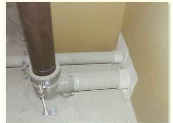
石膏ボード貫通口
