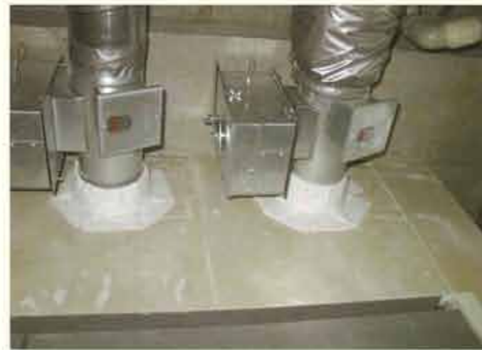
石膏ボード貫通口
