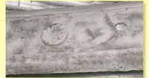
No.3 耐火被覆材吹き付け後
