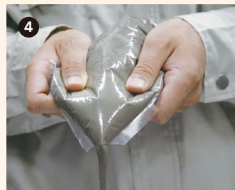
4 パックの切り込み部をカットしてモルタルを押し出します。
